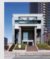
▲南口エントランス
