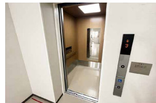
▲エレベーター
