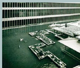
中庭池と厚生棟
