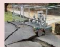
水道の復旧 (被災した浄水場)
