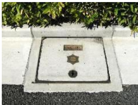
設置した雨水浸透枡
