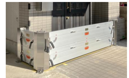
止水板の設置例
