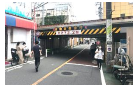
桁下の低い架道橋による緊急車両等の通行阻害 東急東横線会第一架道橋(桁下2.2m)
