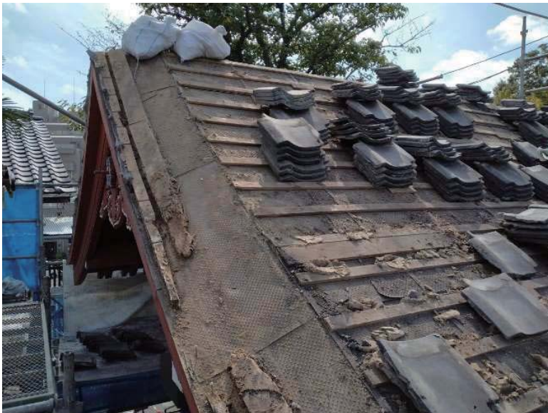
瓦撤去中の屋根のようす
