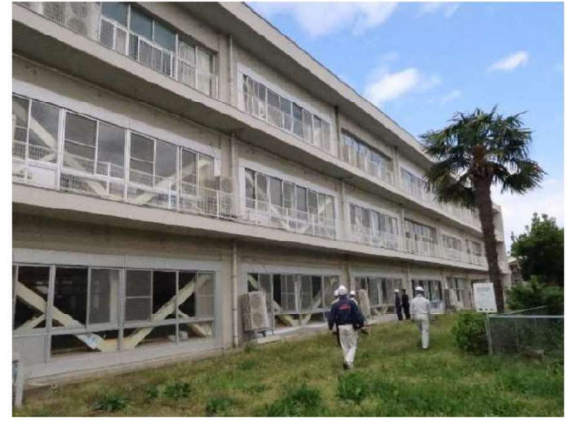
耐震改修を行った鉄筋コンクリート造建築物
