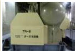
▲電動式ターボ冷凍機。水よりも冷たい蒸気を電気力で高温高压にする。次に冷やして液体にする。これが気体になるときの気化熱を使って常温の水を冷たい水にする。写真の機械 TR-8 は、東日本大震災の直前に搬入された。
