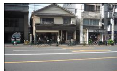
アーケード撤去後の様子
