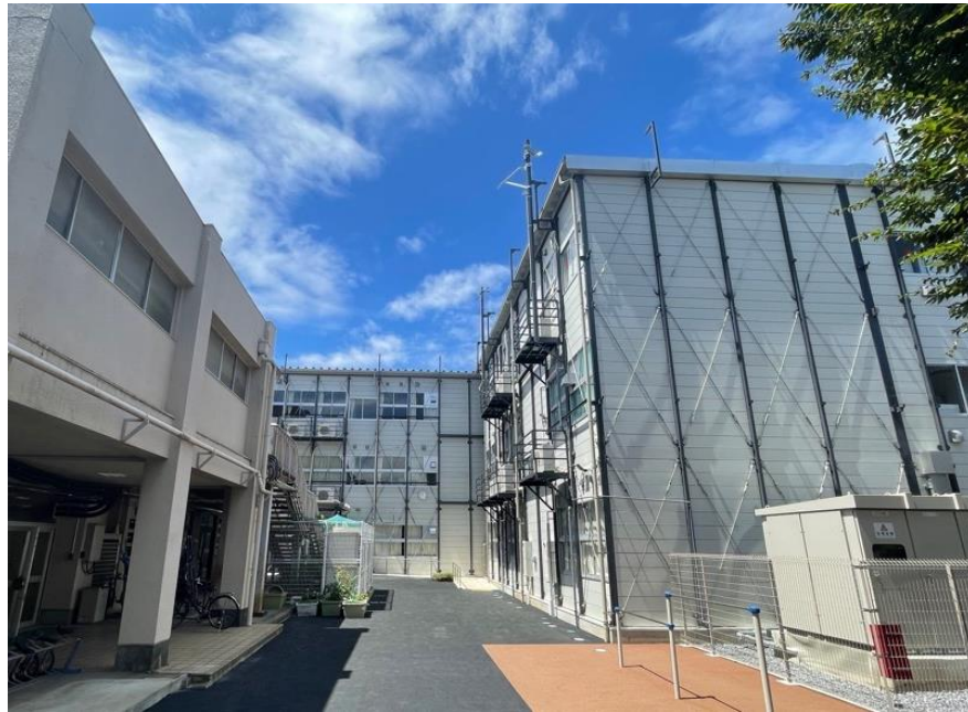
▲仮設校舎建設後の建物全体（令和6年8月上旬撮影）
