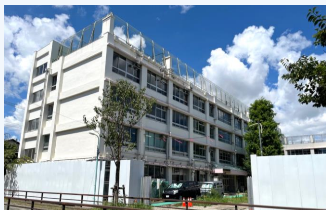
▲解体工事準備の様子
