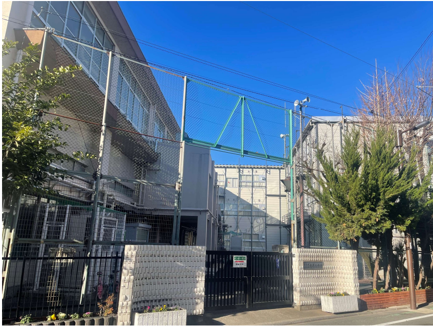
▲仮設校舎建設後の建物外観（令和7年2月5日撮影）
