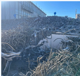
▲既存校舎解体の様子
