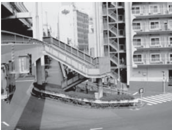
246号線横断-歩道橋(環6支線)
