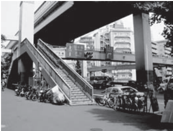
246号線歩道橋付近
