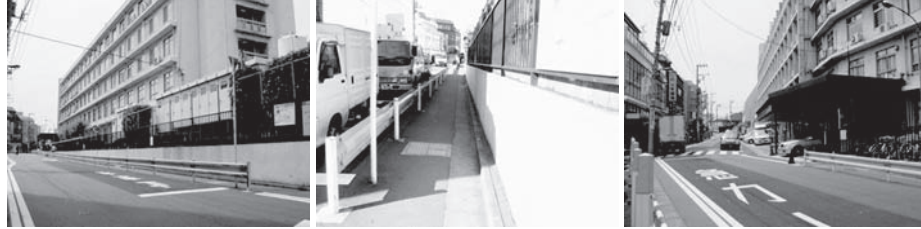
大橋図書館付近（通過交通・手すりや階段の不揃い）
