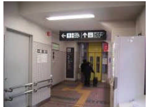
駅構内のエレベーターと、視覚障害者誘導用ブロック及び二段手すりの事例（都立大学駅／目黒区）
