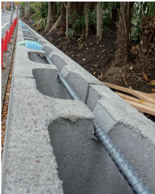
改修のようす 基礎のブロックの鋼材での補強 (令和4年12月13日現在)
