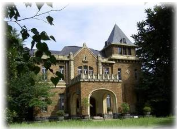
旧前田侯爵邸洋館（駒場公園）
