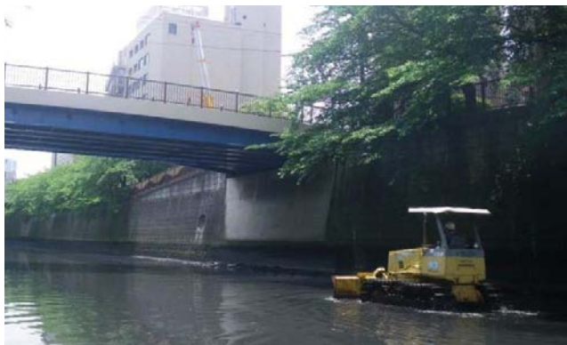
目黒川における川底の均し工事
