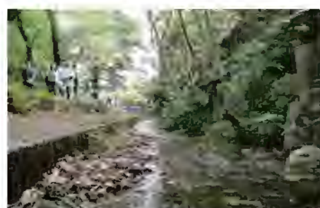
写真 湧水の流れ(駒場)
