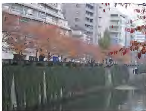
写真 フユツタによる目黒川護岸の緑化
