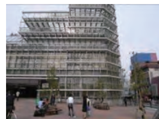
写真 建築物の緑化例
