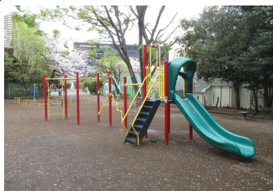
複合遊具の修繕
