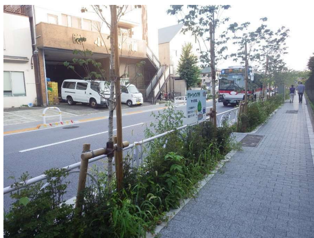
道路の植栽帯を活用した貯留浸透 透水性インターロッキングブロック
