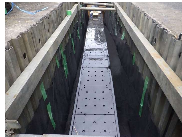
道路の地下貯留浸透槽
